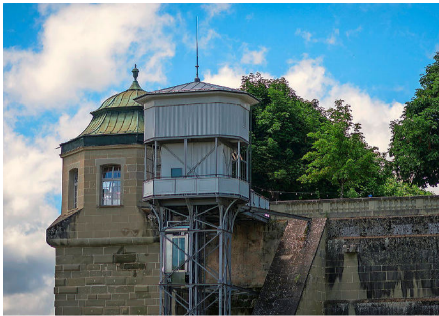
Mattelift in Bern: Der Aufzug mit seinem Stahlskelett feiert 2020 den 125. Geburtstag.
