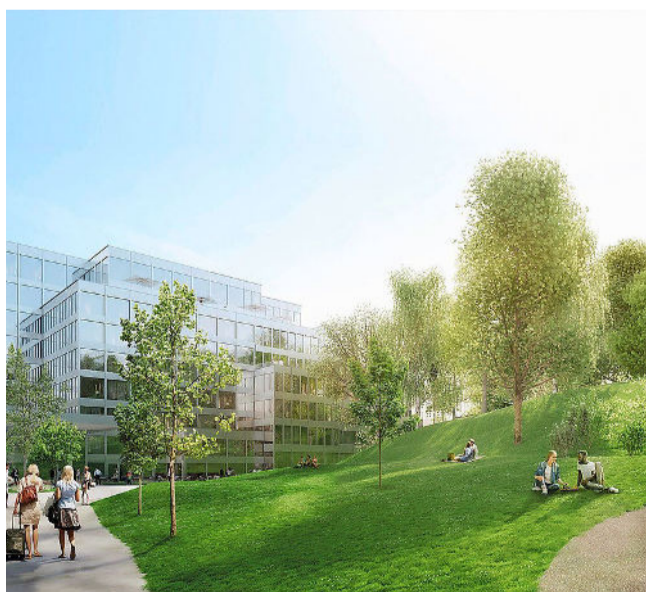
The Circle beim Flughafen Zürich: Der neue Place to be soll zum Zentrum werden, das Zürichs Attraktivität zukunftsweisend prägt.
