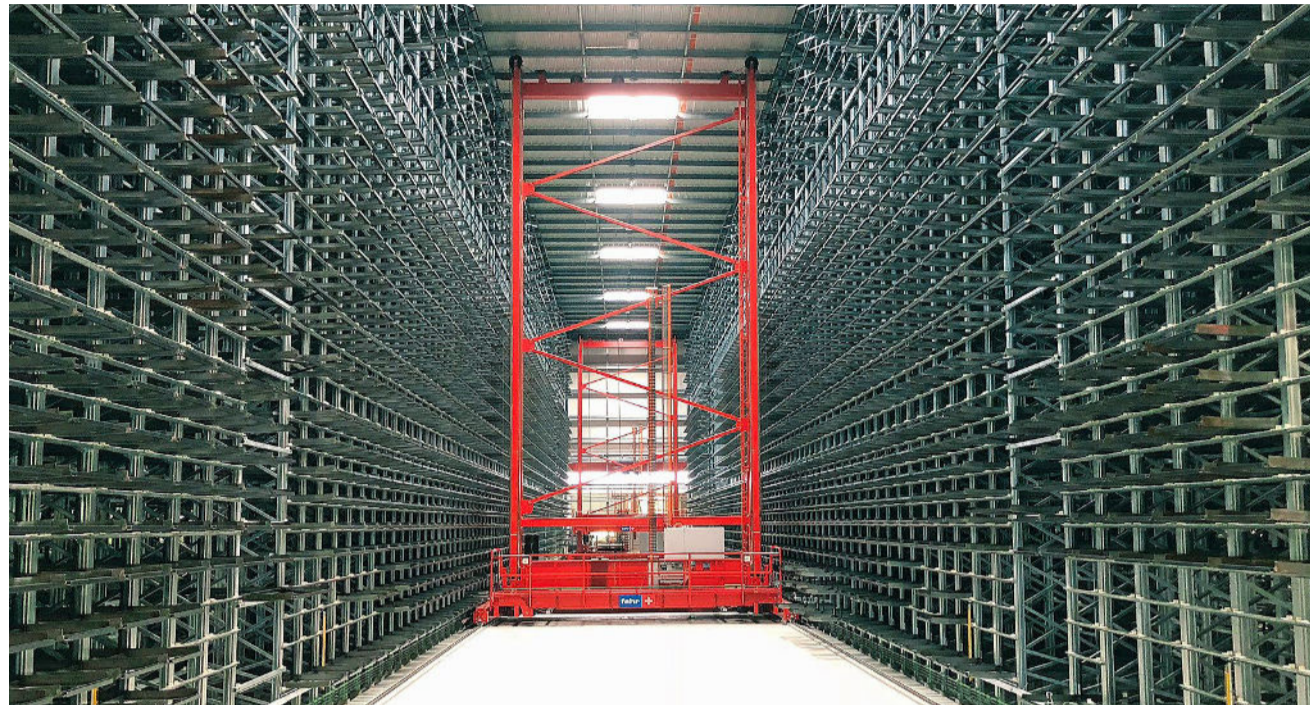
Zentrallager in Dietikon: Durch die Teil- und Vollautomatisierung wurden die manuelle Arbeit sowie die Rüst- und Ladezeiten verringert.
