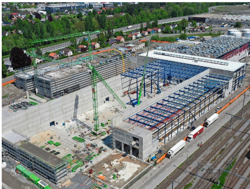
2500 Tonnen Stahl für Stadler Rail: Auf dem Altfeldareal beim Bahnhof St. Margrethen geht das Kompetenzzentrum für Doppelstocktriebzüge seiner Realisierung entgegen.
