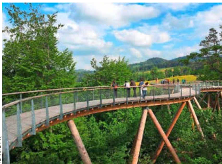
Baumwipfelpfad: Für diesen wurden über 62 Tonnen Stahl der Debrunner Acifer AG verbaut, dies in Form von Massblechen, Stabstahl, Rohren und Hohlprofilen.
