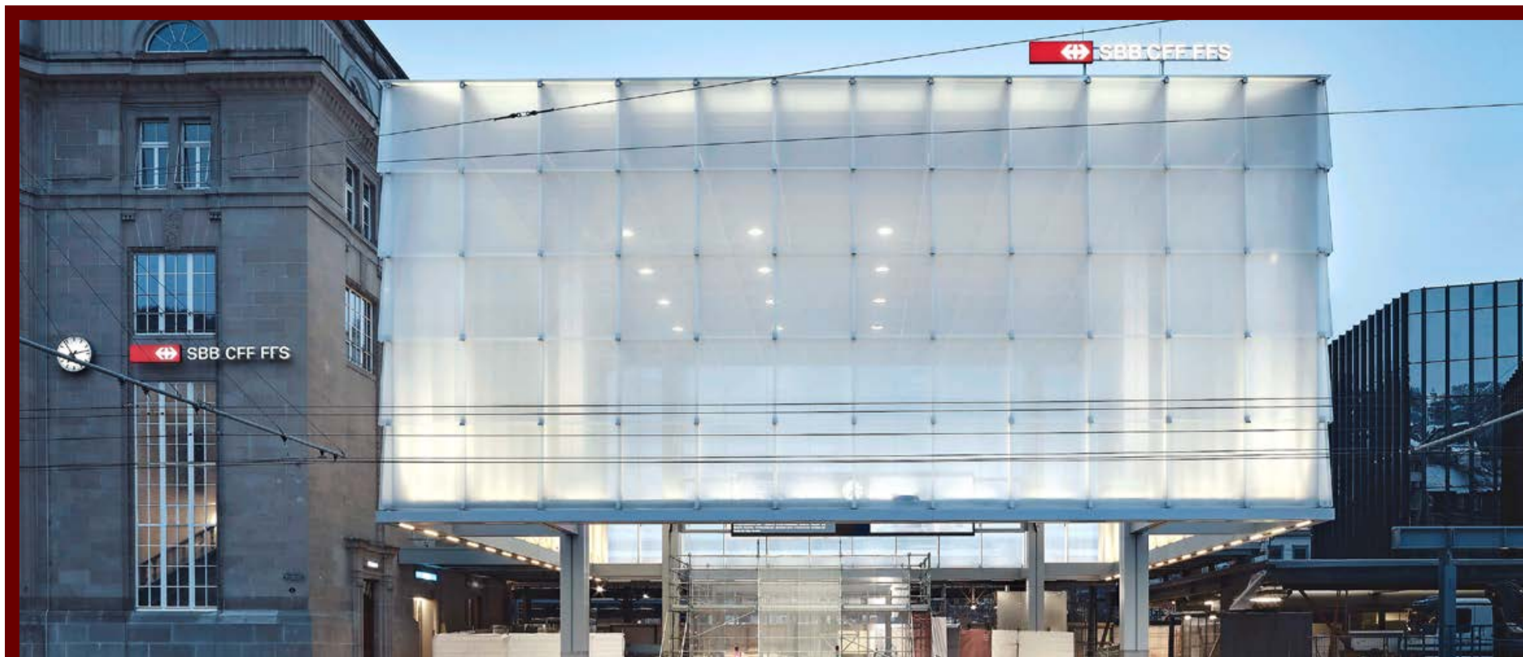
Anerkennung Prix Acier 2018: Ankunftshalle Bahnhof St. Gallen. Architekt: Giuliani Hönger AG, Zürich. Stahlbauer: Tuchschmid AG, Frauenfeld.
