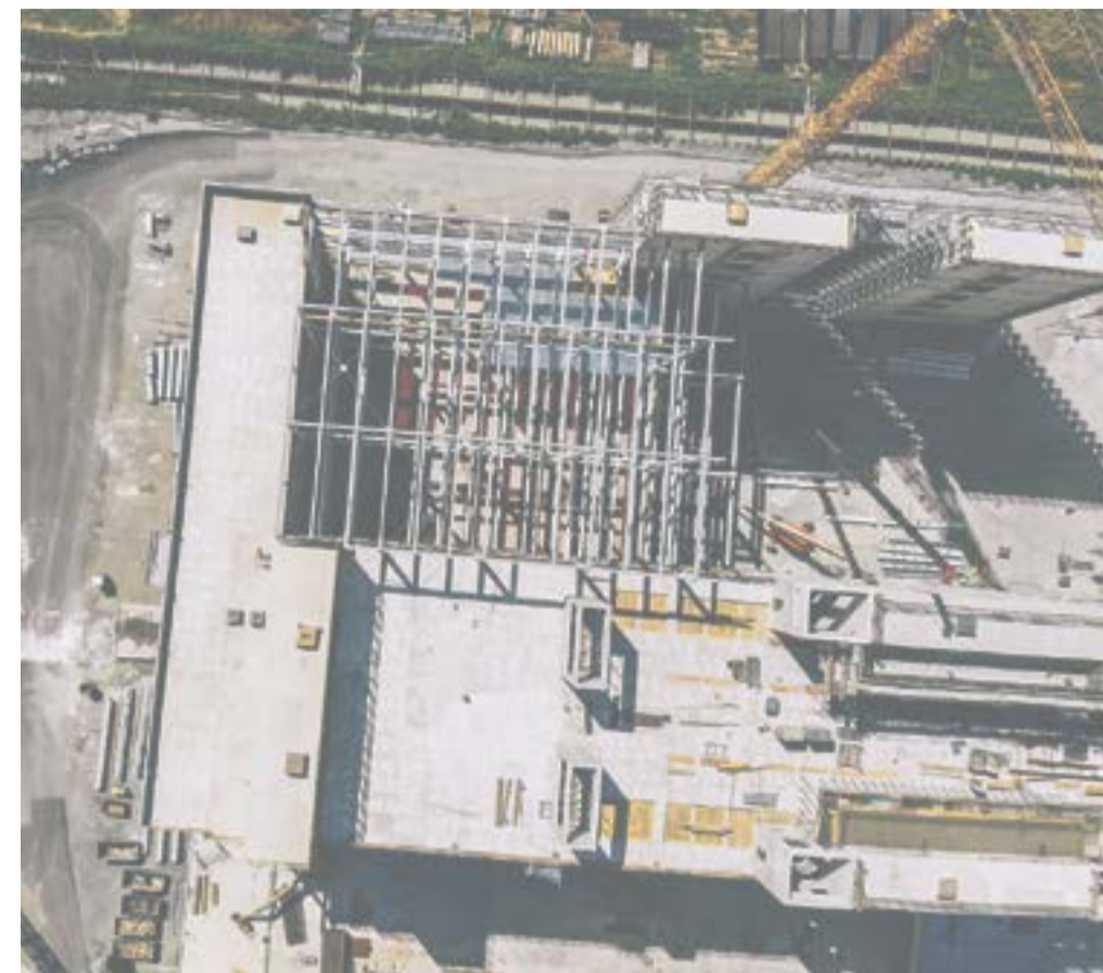
Zusammenhalt: Spannverbundstahlstützen und Beton als tragende Kräfte
