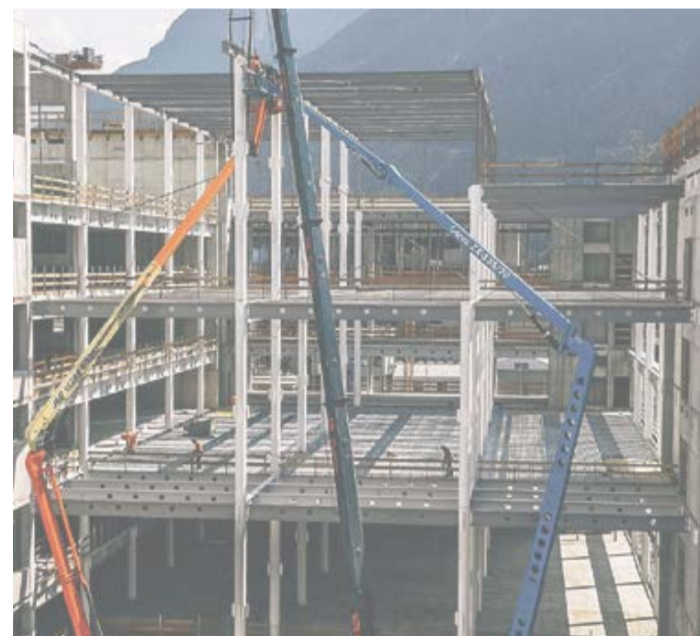
Hoch hinaus: Ein- und zweigeschossige Stahlbaukonstruktionen im 36 Meter hohen Baukörper
