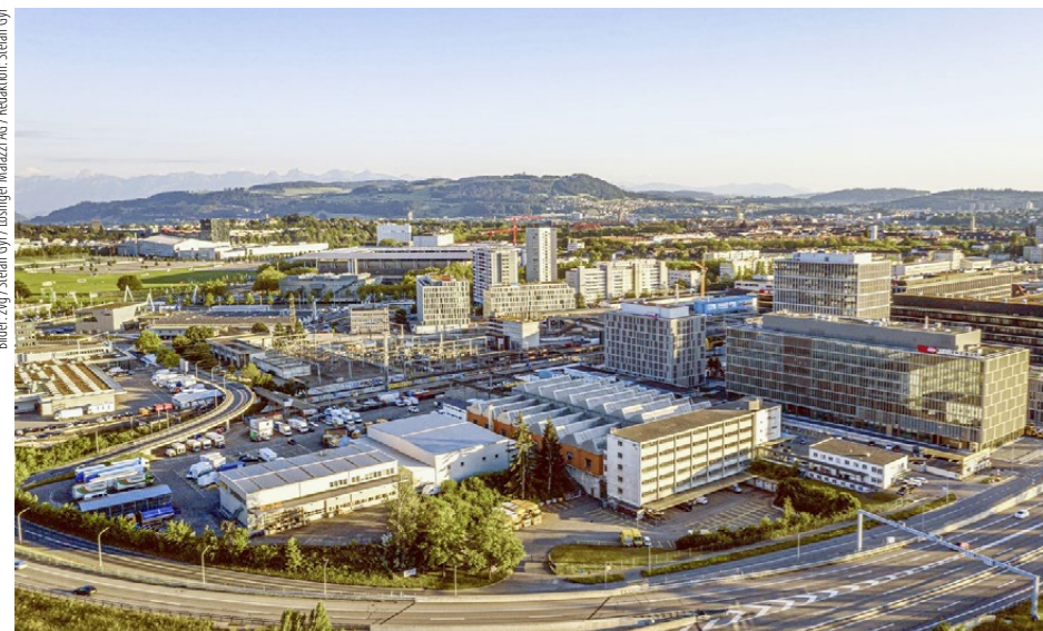
Aus dem heutigen Gewerbeareal soll ein urbanes Wohn- und Arbeitsquartier werden.
