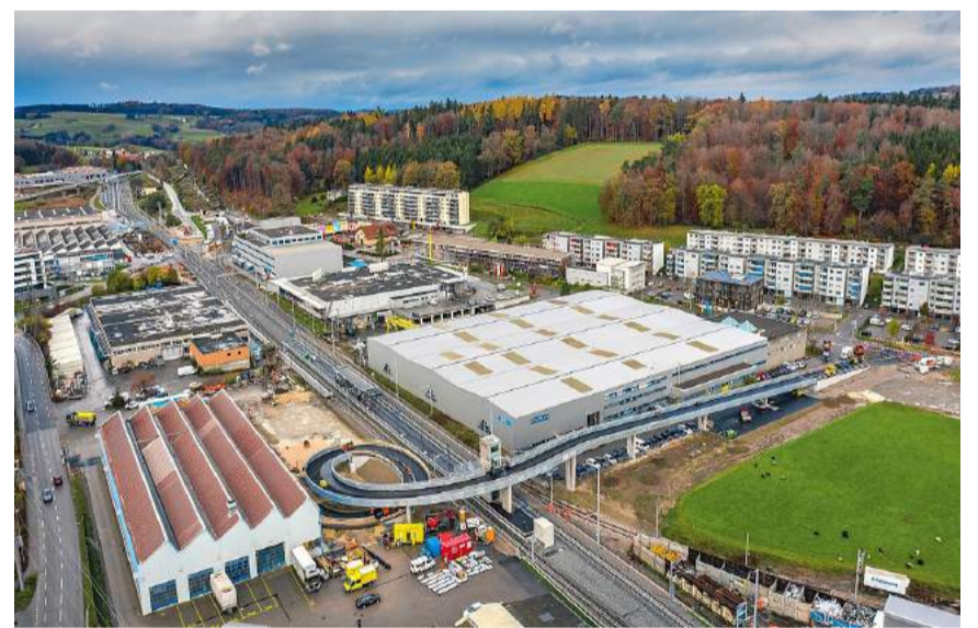
Bahnhof Givisiez: Die 190 Meter lange Passerelle verbindet für den Langsamverkehr (Fussgänger und Velofahrer) die Wohngebiete auf beiden Seiten der Gleise miteinander.
